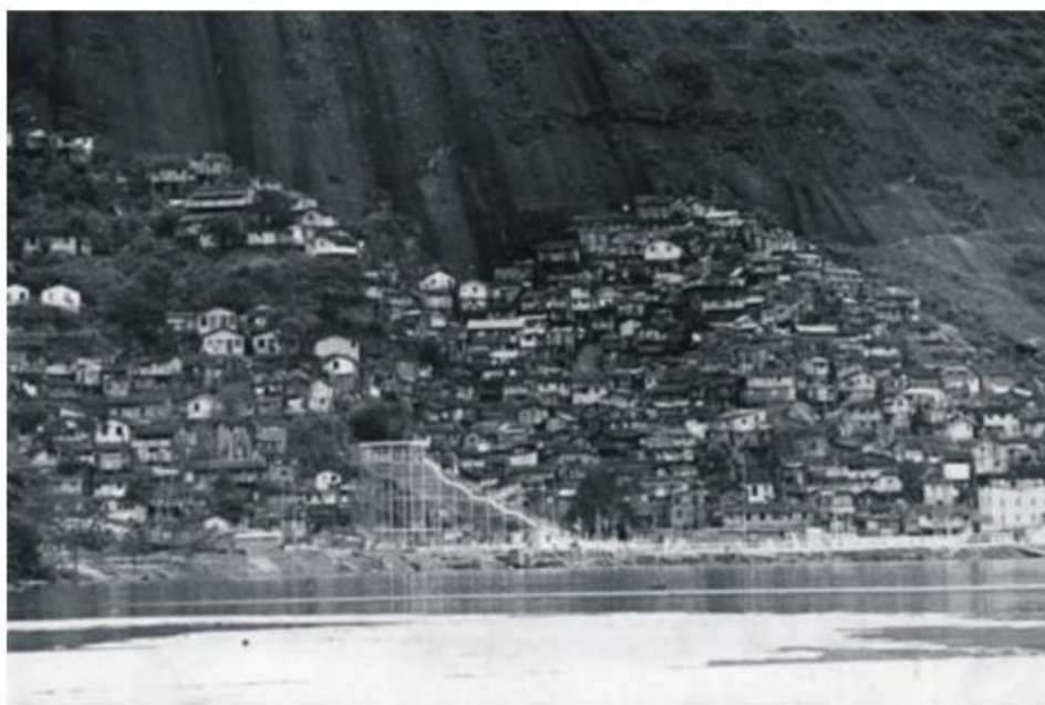
Figura 21 - Favela da Catacumba Fonte: RODRIGUES (2013, p.13)
