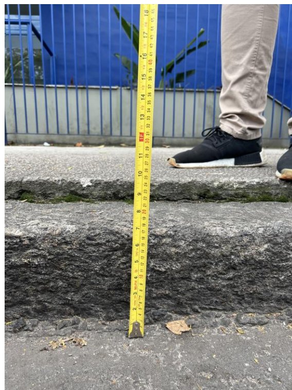
Figura 51 - Medição do desnível de 25 cm entre a rua e a calçada em frente ao Hospital Miguel Couto. Fonte: Autores
