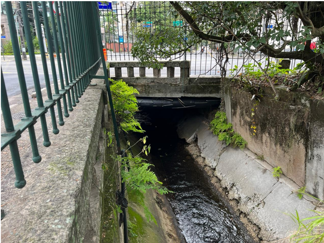
Figura 70 - Rio dos Macacos no trecho antes de entrar na galeria da Rua Jardim Botânico.
